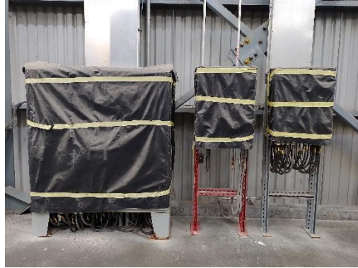
Foto 6. Equipo fuera de operación, debidamente resguardado, para evitar el deterioro de los mismos.
