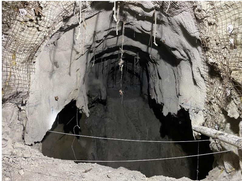
Figura No. 17. Cámara de explotación abierta
