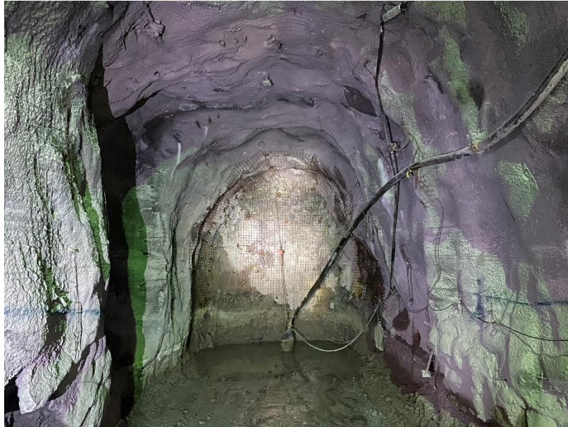
Figura No. 21. Nivel 1170 Sumidero de agua visita 2021
