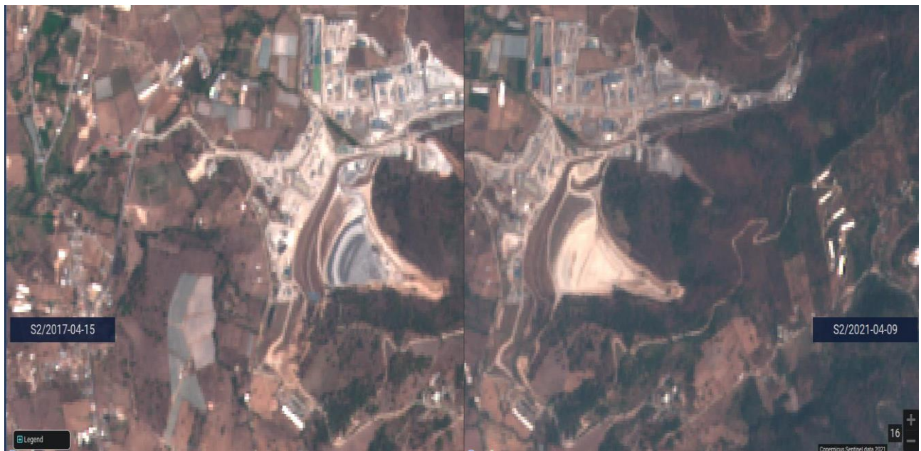
Figura No. 25. Depósito de Colas abril 2017- abril 2021
