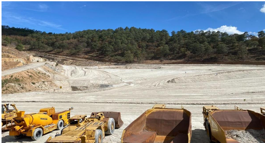
Figura No. 30. Escombrera marzo 2021
