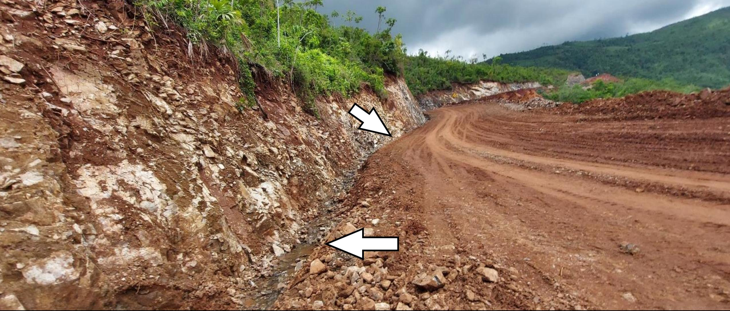
Sistema de drenajes, los cuales contribuyen a encauzar aguas pluviales a cuerpos receptores artificiales (sedimentadores).
