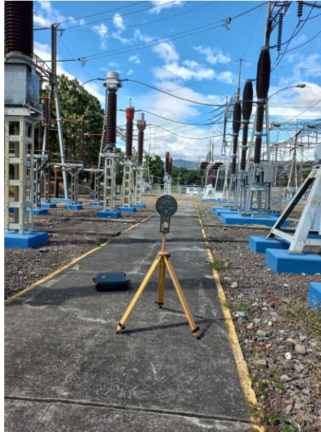
Figura 15: medición en pórtico lateral
