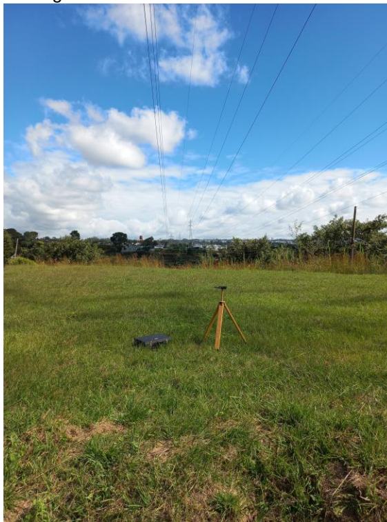
Figura 9: Medición en la línea de 230kV
