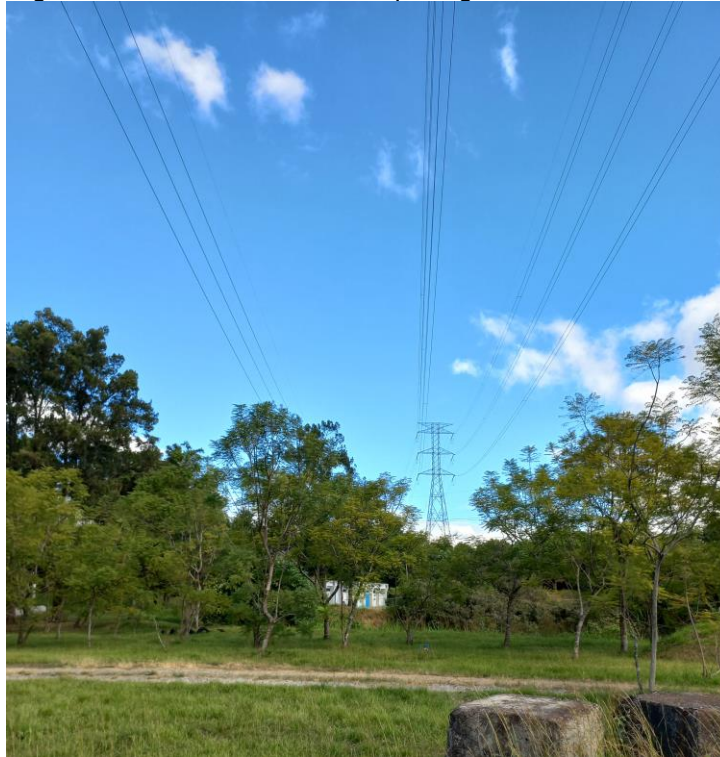
Figura 6: Línea de Transmisión que ingresa a la subestación
