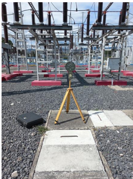
Figura 14: medición en pórtico lateral
