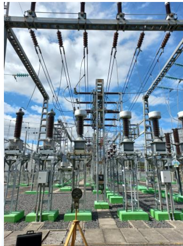
Figura 12: medición en perfil de remate de barras
