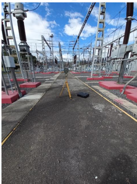
Figura 13: medición en pórtico de remate
