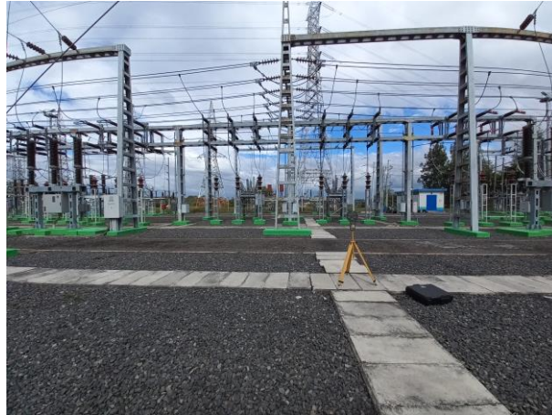
Figura 12: medición en perfil de remate de barras
