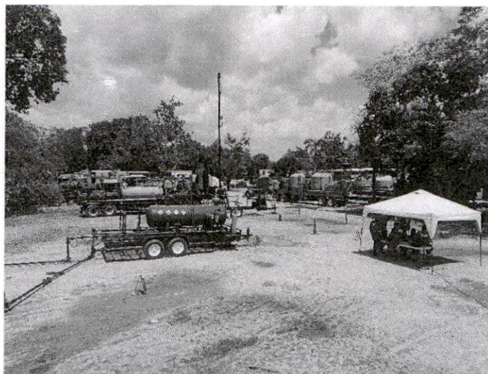
Fotografía 7. Separador Trifásico Horizontal:
