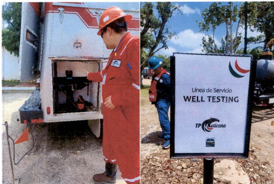
Fotografía 5. Unidad de Well Testing
